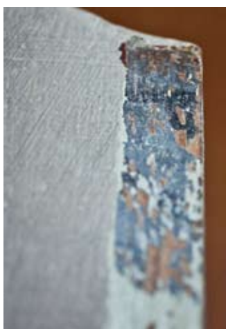
Odkrywka w partii tralek łóż kolatorskich. Widoczna źle zachowana spodnia warstwa polichromii.
