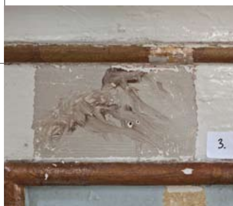
Przekrój stratygraficzny próbki pobranej z ołtarza pokazuje 5 warstw przemalowań wtórnych. Poniżej miejsce pobrania próbki.
