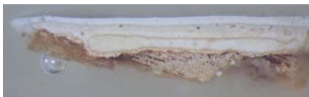
Przekrój boczny próbki pobranej ze ściany na chórze.
